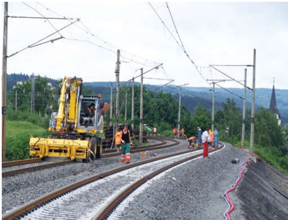
FINÁLNÍ ÚPRAVA. K betonovým pražcům jsou připevněny bezстыkové svařené koleje. Foto: Pavel Richter
